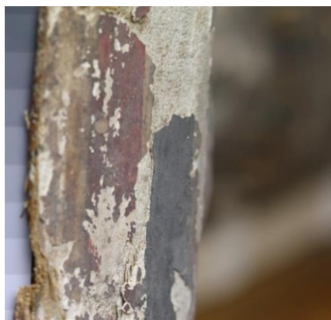
Figure 28 : Vue de face de la partie des pieds de la partie supérieure. La zone est empoussiérée et encrassée. La couleur est impactée. ©He-Arc 2024, Marine Roux
